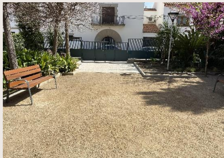
A l'actualitat després de l'obra
